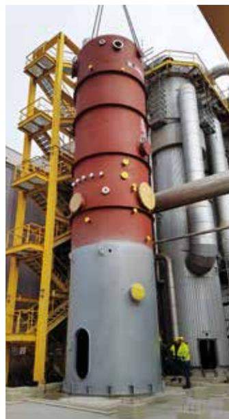
Verdampfer für eine deutsche Zuckerfabrik mit einer Leistung von 53 Megawatt und einem Gesamtgewicht von 80 Tonnen)
